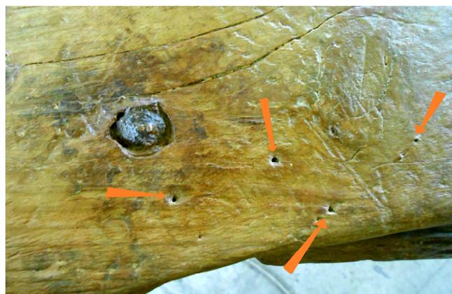
**Fig. 14:** *Dettaglio della tavola in legno con la presenza di piccoli fori in prossimità di uno dei chiodi in ferro -il quarto dall'alto- (rielaborazione da foto di A. Gobbi)*
