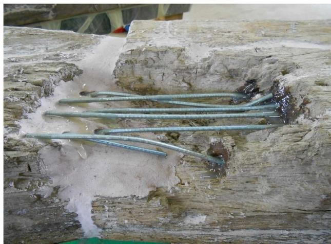
**Fig. 10:** Ricomposizione degli elementi strutturali con l'impiego di barre filettate in acciaio inossidabile, resina epossidica bicomponente e balsite (foto di Andrea Gobbi)
