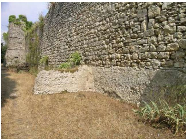
*Fig. 80: Saturnia, il Cassero (421). Muratura a monte della cisterna, su cui poggiano le strutture del castello, e tramezzo tra secondo e terzo ambiente.*
